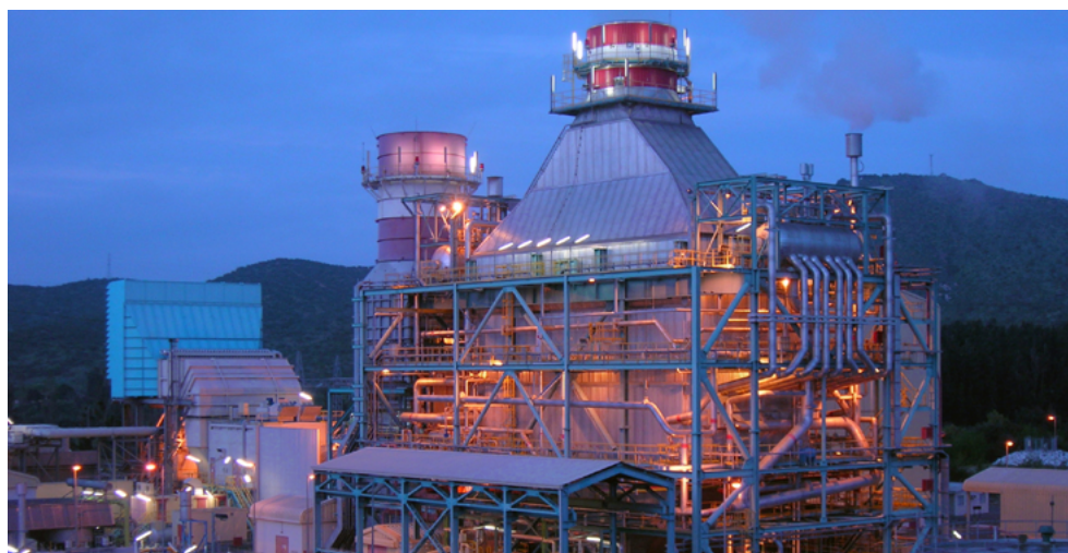
Centrale thermique à cycle combiné à Quillota, Chili
