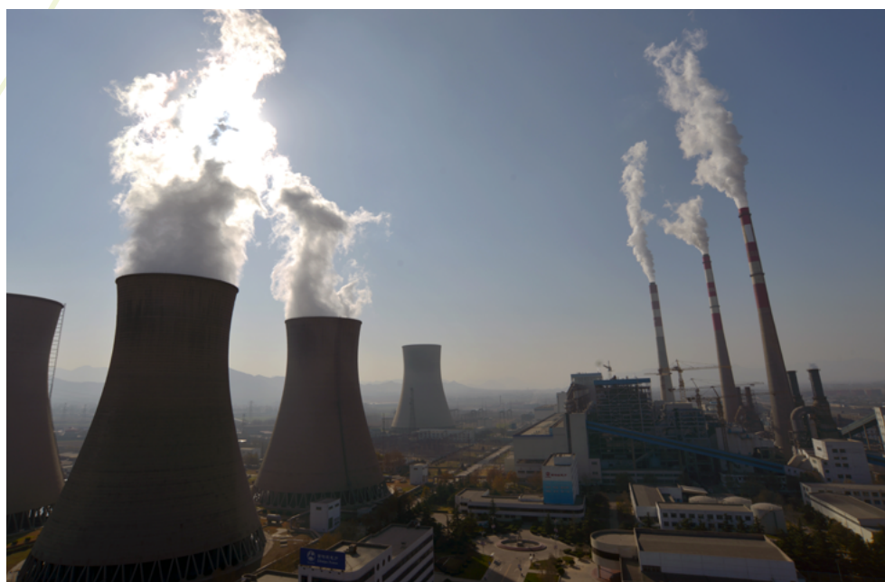
Photo : Centrale thermique à charbon d'une puissance installée de 2 400 MW. La production d'électricité est un secteur clé des programmes Top 1 000 et Top 10 000, Aisa, Chine, province du Hebei, ville de Shijiazhuang, district de Pingshan
