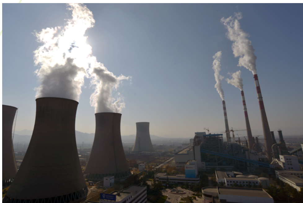
Central eléctrica alimentada por carbón, con capacidad instalada de 2400MW. La generación de energía es un sector clave del Programa para empresas 1000/10000, Asia, China, Provincia de Hebei, Ciudad de Shijiazhuang, Condado de Pingshan © Wu Di / Greenpeace
