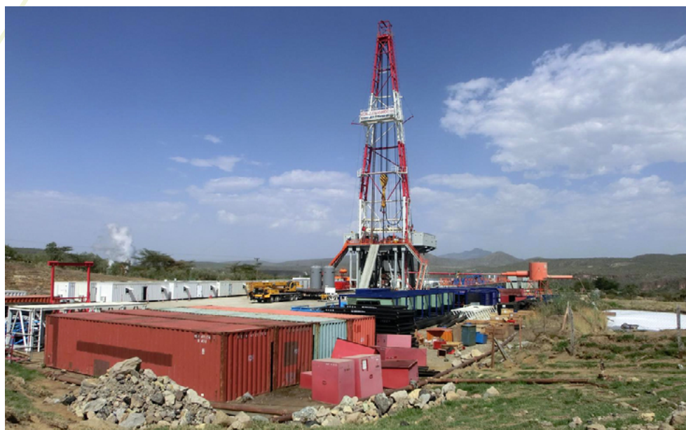
Forage géothermique KenGen, Olkaria, Kenya
