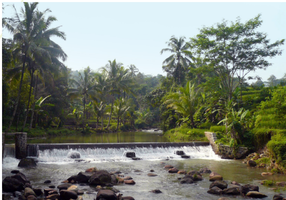
Central microhidráulica en Java occidental, Indonesia
