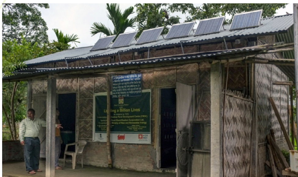
Sistema Solar PV distribuido para electrificación rural
